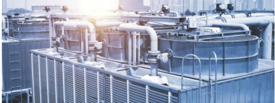
La presencia de gases disueltos en el agua de suministro, aunado a la práctica frecuente de operar los equipos con agua de tendencia corrosiva, propicia el deterioro prematuro de los equipos de transferencia de calor.
